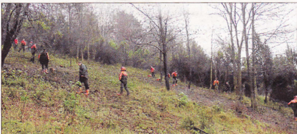
Ce chantier a servi d'exercice d'évaluation aux élèves de bac pro. (Photo C. Petit).
